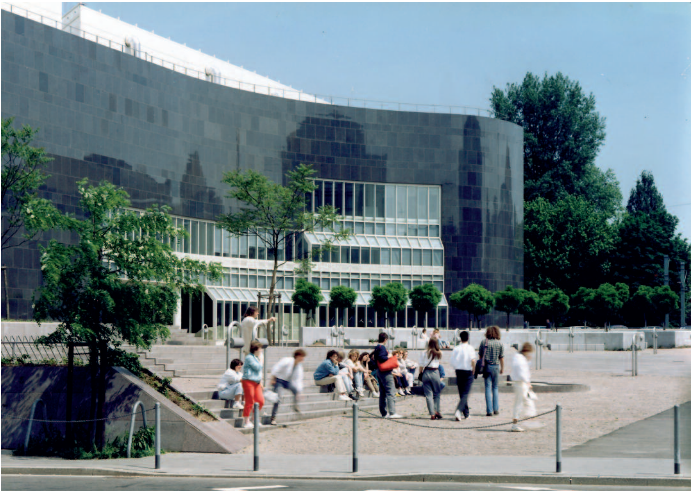
Beispiel für eine gelungene Dachsanierung von Meyer Architekten: Museum K20 Kunstsammlung Nordrhein-Westfalen in Düsseldorf.
