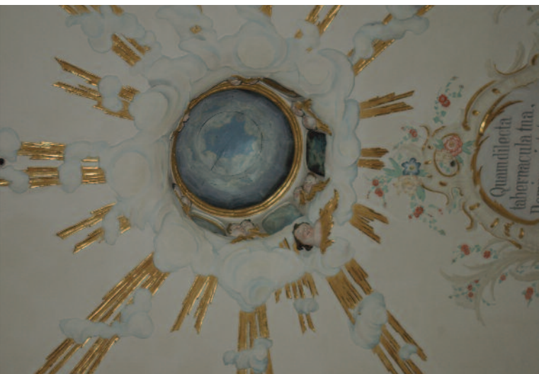
St. Bartholomäus, Hörgersdorf: In einer der schönsten Rokokokirchen Bayerns wurde die Hl. Geist Öffnung für die Führung von Zuluft umgebaut.
