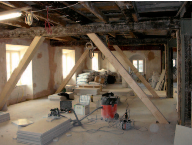
Dachgeschoss: Das linienaufgelagerte und freitragende Bodensystem LBS dient dem Niveaueingleich. © Knauf Integral
