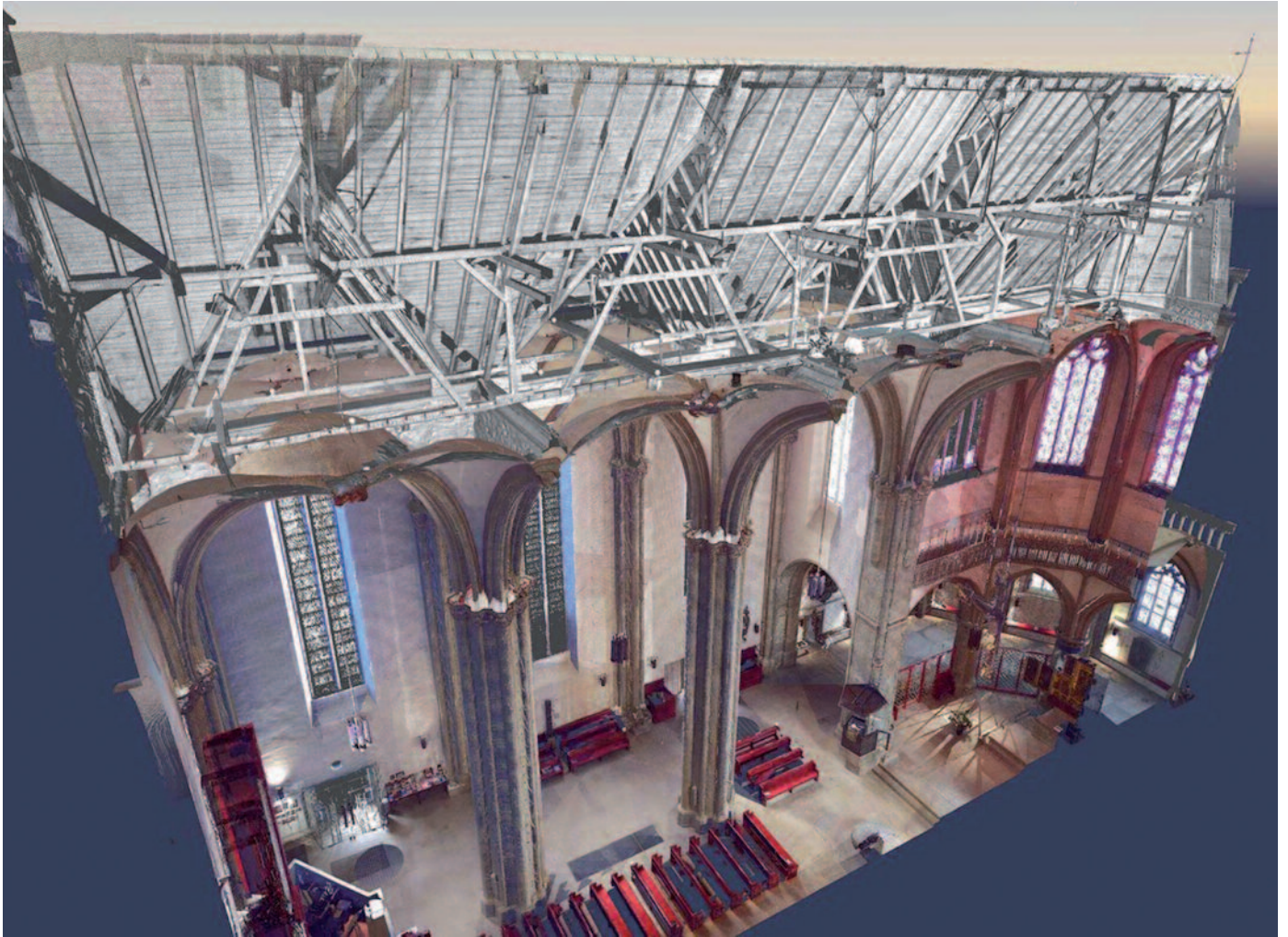
links: Via Bildschirm durch das Portal von St. Marien in Osnabrück; oben: Auch der Innenraum der Kirche sowie der Dachstuhl sind mithilfe des Laser Scanners exakt dokumentiert; unten: Auch für bauliche Planungen von großem Nutzen: Aus den 3D-Daten erstellter Grundriss der Kirche. © / alle Abb.: laser-scanning-architecture.com
