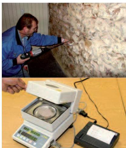
Bohrprobenentnahme und Auswertung der Mauerfeuchte mit der mobilen Darr-Messanlage; © ECODRY Systeme; Foto: Klaus Breitenbach
