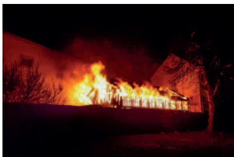
Dezember 2018: Brand eines Holzlagergebäudes für die historische Heizung der Orangerie in Belvedere/Weimar. Ein Übergreifen des Brandes auf die Orangerie konnte verhindert werden.
