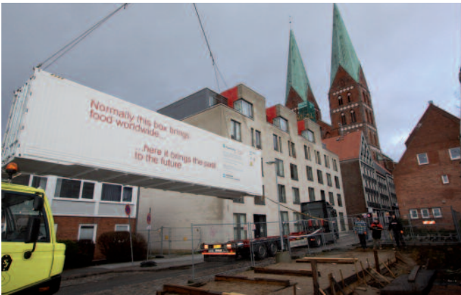
Anlieferung der Container auf der Grabung Gründungsquartier Lübeck (alle Abb. © Lars Klemm, Fraunhofer IBP)
