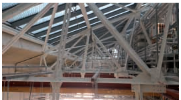
Staubdach der Kunsthalle: Spiegelraster (oben), Gebäudetechnik (rechts), Beginn der Lichtdecke (unten), © Volker Huckemann
