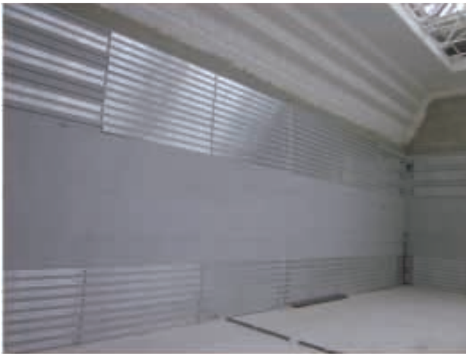
Wand mit Hängezone (im Bauzustand)
