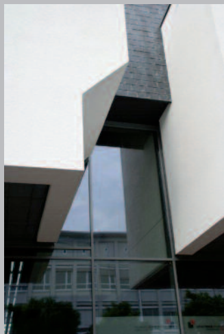
Fassade nach der Sanierung Bildnachweise: © LUWOGÉ consult GmbH
